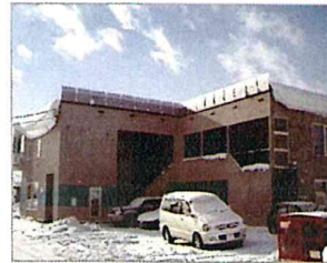
▲スノーガードN施工写真
